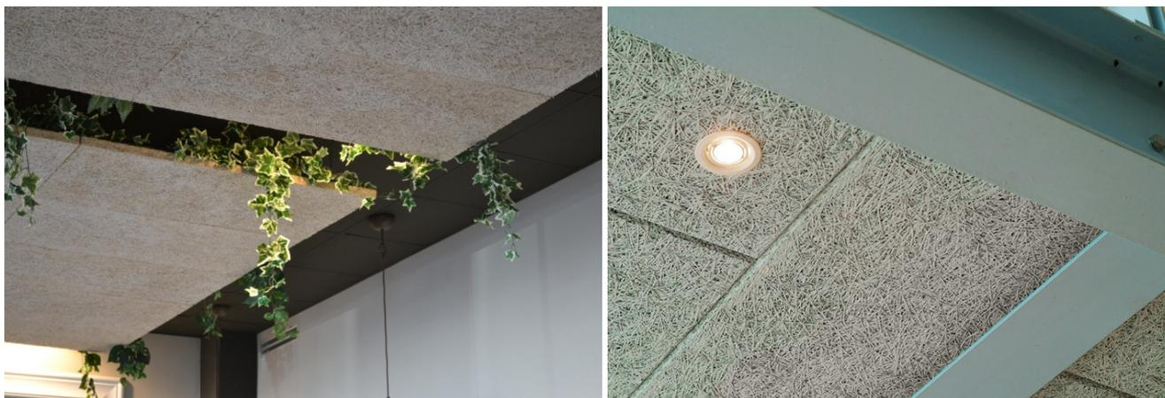
O Celenit possui uma durabilidade ilimitada. As fibras são submetidas a um tratamento mineralizante que formam uma estrutura estável, resistente, durável e compacta. É eco-sustentável, não cria emissão de fumos e gases tóxicos, assegurando uma absoluta segurança em caso de incêndio. Os painéis de Celenit são também insensíveis à água e ao gelo, atuando ainda como um regulador higrométrico e garantindo assim um alto grau de conforto ambiental nos espaços onde estão aplicados.
