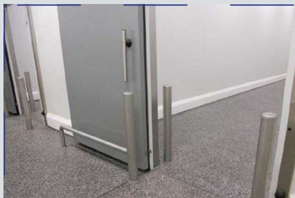
PolySto aplicado em postes e barras de aço inoxidável e OP30RB Sanicoat com um rebaixo aplicado ao pavimento em granito
