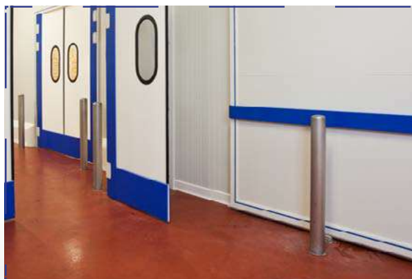
PolySto construído em postes de aço inoxidável e OP10F aplicado em pavimento de betão.
