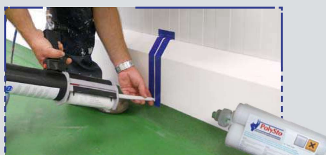
PolySto OP30RB Sanicoat com pavimento em epoxy criando um rebaixo e com acabamento com PolySto Saniseal.
