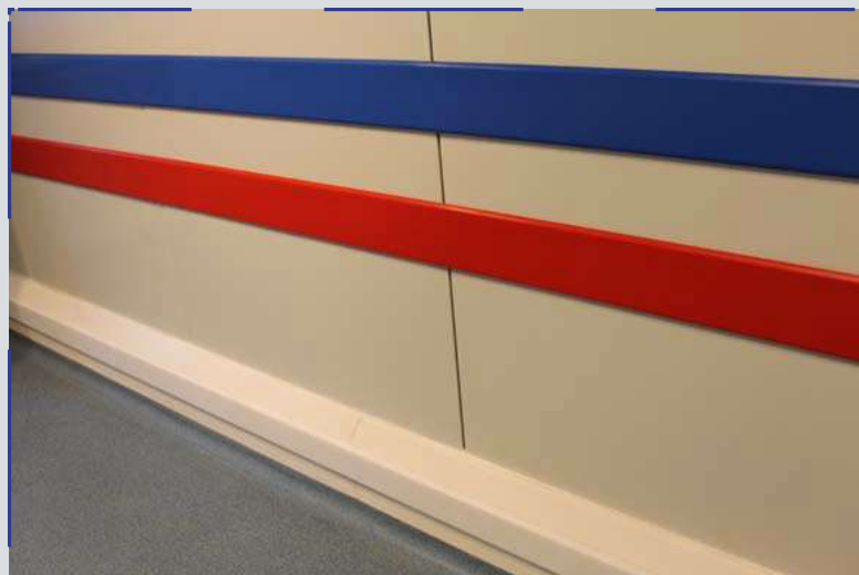
PolySto OP30RB (impacto extremo opcional) com aplicação de pavimento epoxy a um rebaixo e faixas de PE vermelhas e azuis.
